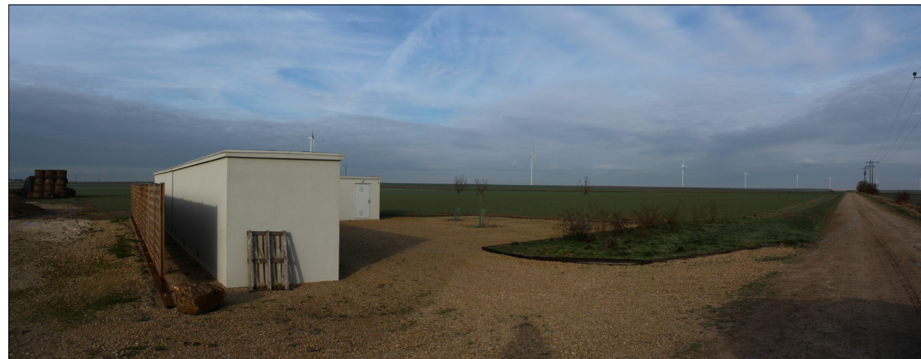
Photographie de l'état existant, vue rapprochée
